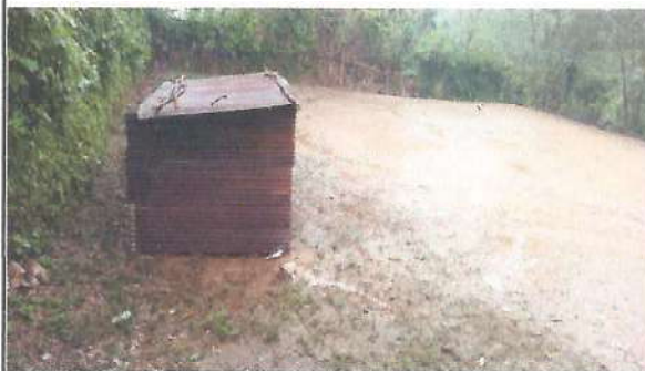
Foto 2: mejoramiento de estructura y techo
