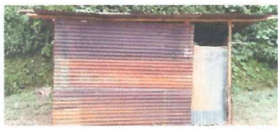
Foto 7: instalación de puerta y ventanas a módulo de aula tipo pórtico
