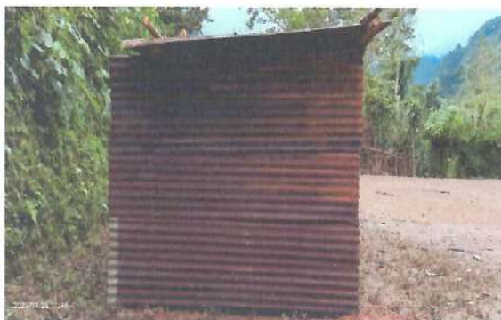
Foto 1: módulo de aula tipo pórtico
