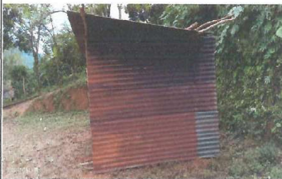
Foto 4: mejoramiento de estructura y techo
