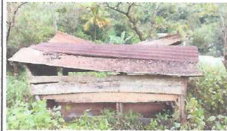
Foto 6: Servicios sanitarios y sus accesorios
