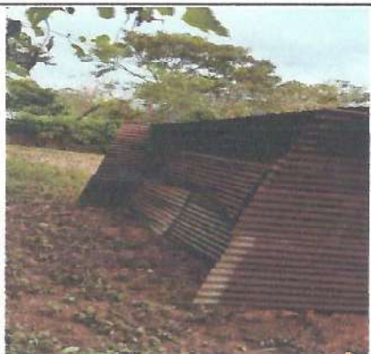
Foto 3: módulo de aula tipo pórtico
