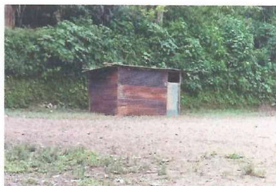
Foto 6: instalación de puerta y ventanas a módulo de aula tipo pórtico
